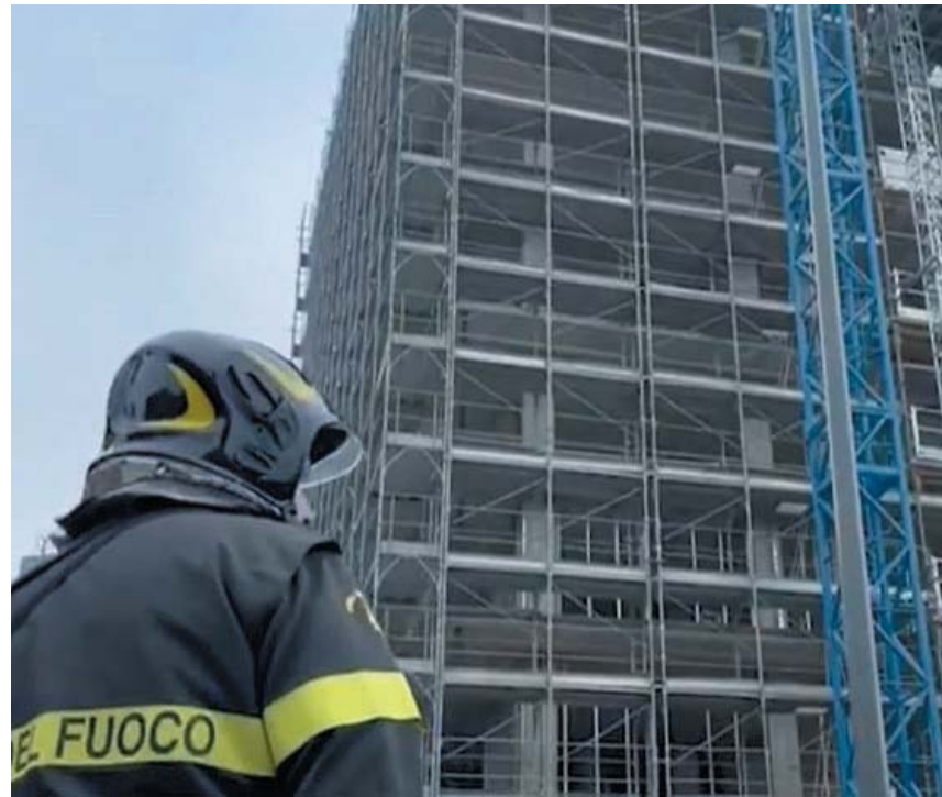
Cantiere Il palazzo in ristrutturazione teatro dell'ennesima tragedia sul lavoro
